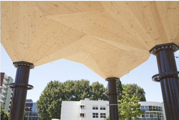
Die Holzschalen werden von acht Stahlstützen getragen
