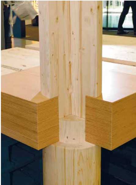
Fichten- und Buchenschnitten ergeben die biegefesteste Brettsperreholzplatte, in die die Holzsäule gesteckt wird: 1-zu-1-Modell und Skizze (Foto:chr)
