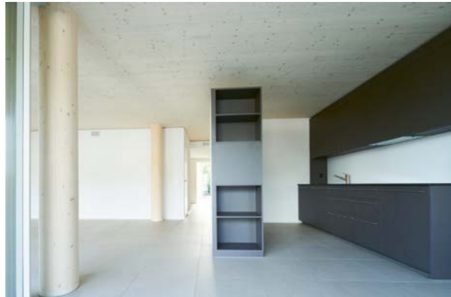
Die TS3-Verbindungen sind in der fertigen Decke kaum sichtbar.
