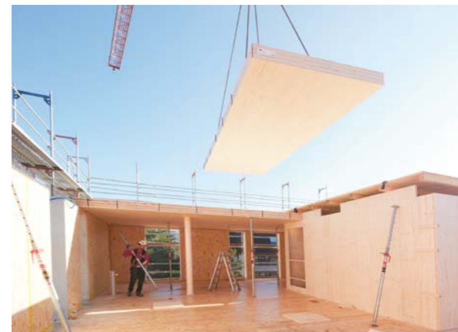
Bau des Mehrfamilienhauses Fasanenhof in Frenkendorf
