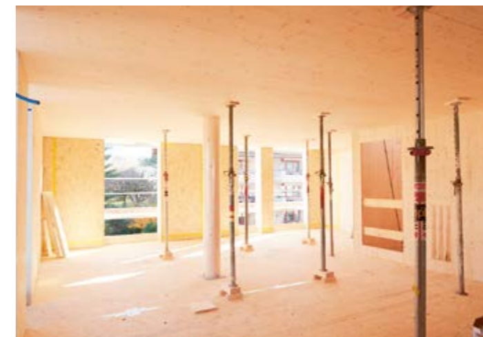
Dank einer minimalen provisorischen Abstützung können nachfolgende Gewerke bereits vor dem Fugenverguss mit ihren Arbeiten beginnen.
