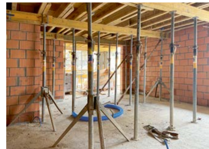
Bei Stahlbetondecken sind wegen des höheren Gewichtes viel mehr Baustützen notwendig.
