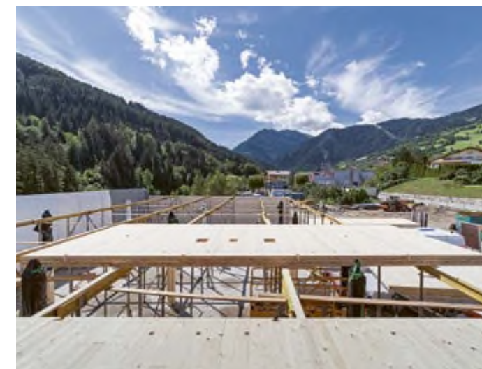
Lehrgerüst für die Montage der TS3-Decke
