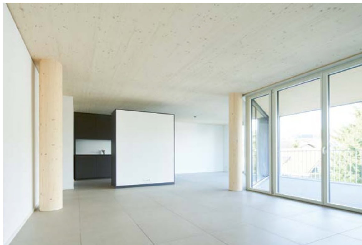
Die TS3-Verbindung ist in der fertigen Decke kaum sichtbar
