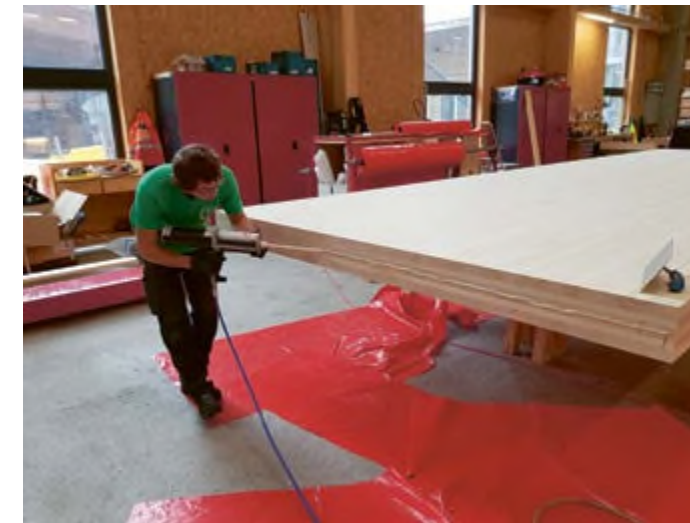
Auftrag der Vorbehandlung im Werk
