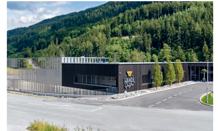
Bâtiment commercial Handl, Haiming Tirol
