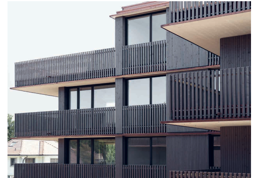
Immeuble collectif Unterhueb, Zollikerberg
