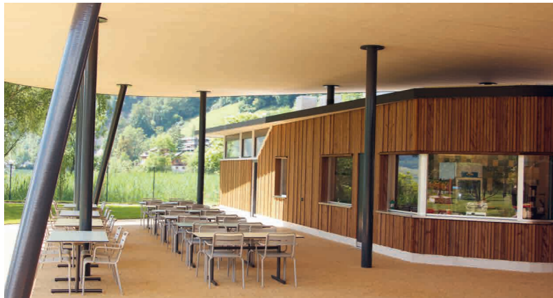
Piscine Hopfräben, Brunnen
