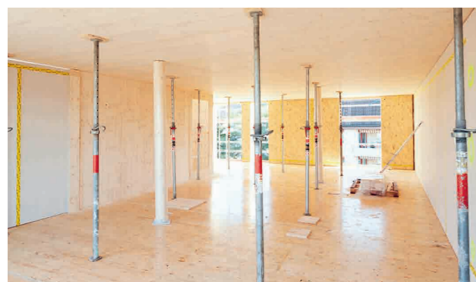
Grâce à un soutien provisoire minimal, les corps de métier ci-après peuvent se mettre au travail avant même le scellement des joints.
