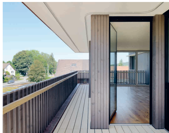
Immeuble collectif Unterhueb, Zollikerberg
