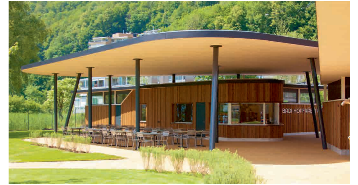
Piscine Hopfräben, Brunnen
