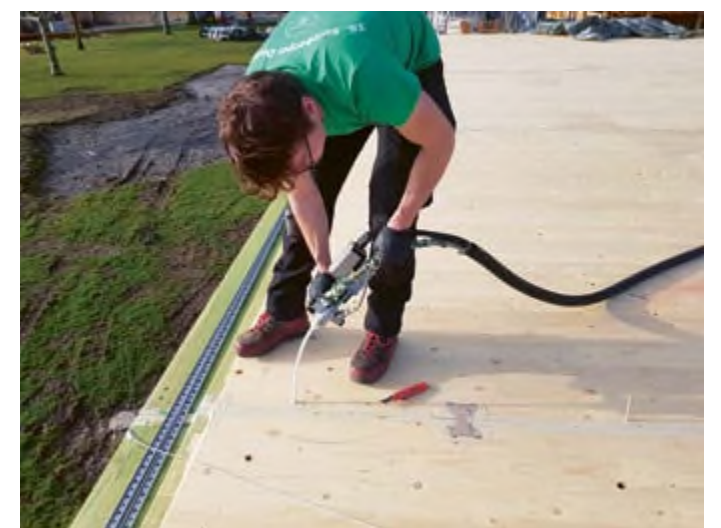
Scellement des joints
