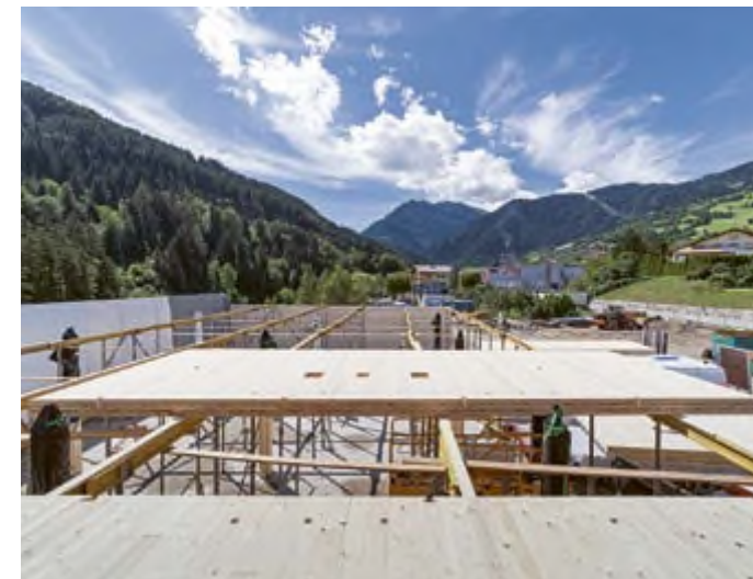
Cintre pour le montage de la dalle TS3
