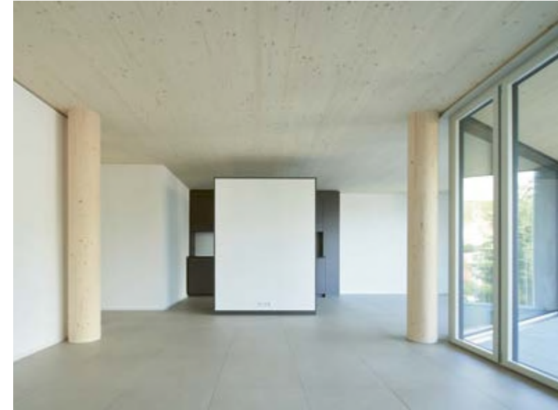
Bâtiment résidentiel classique sans murs intérieurs porteurs et sans poutres pour une flexibilité totale
