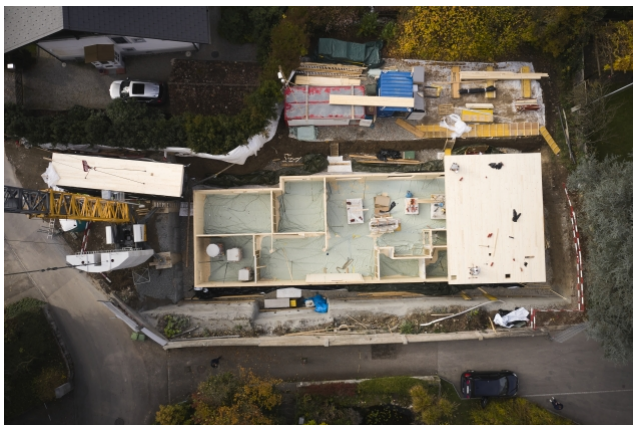
Ce qui a longtemps semblé impossible est aujourd'hui une réalité : à Thoune se trouve le premier immeuble d'habitation avec une cave entièrement en bois.
