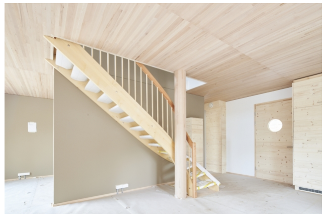
La technologie TS3 permet une construction poteaux-dalles. Les joints TS3 restent visibles dans ce projet.
