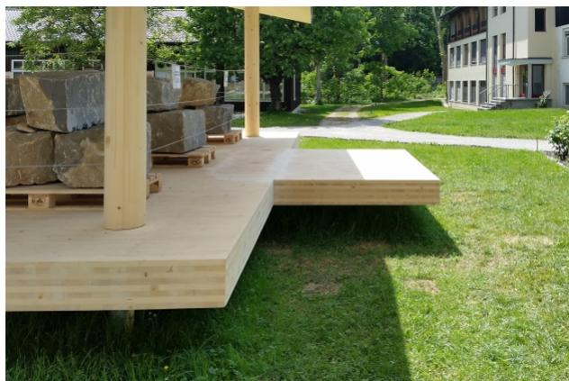
Poteaux, panneaux, c'est prêt: dans la cour intérieure de la Haute école spécialisée bernoise à Bienne, un banc d'essai permanent a été installé, intégrant la technologie TS3 et le tout premier balcon au monde collé sur face frontale. Cette installation met en évidence les nouvelles possibilités offertes par la technologie TS3 pour la construction bois.
