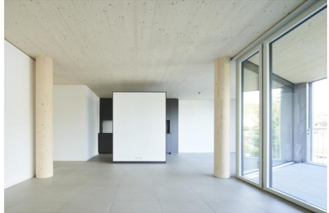
À Frenkendorf, la première construction à quatre étages avec piliers et dalles en bois a été réalisée grâce à TS3, permettant de remplacer le béton initialement prévu. La planification avec des panneaux de bois lamellé-collé à axes porteurs multiples est comparable à celle du béton armé.
