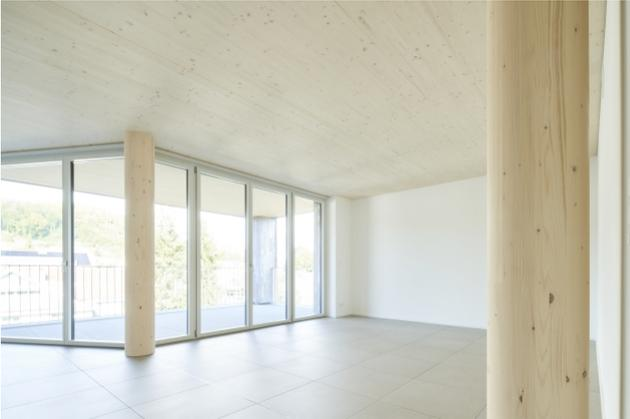
Grâce au support porteur, les murs ne sont pas porteurs et peuvent être facilement déplacés.
