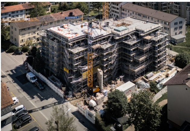
Immeuble résidentiel - phase de construction 1
