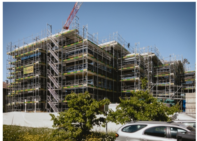
Immeuble résidentiel - phase de construction 2
