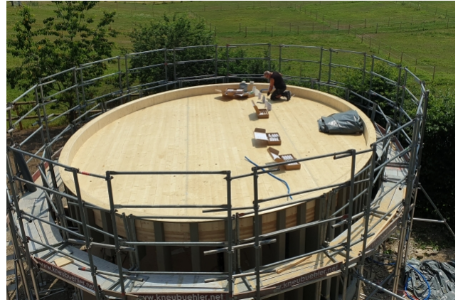
Travaux de montage sur le toit du pavillon
