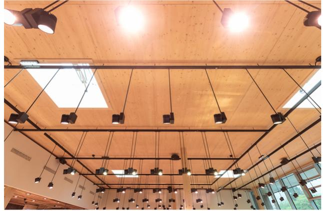
Panneaux CLT sur les poteaux en bois avec une trame de 7 x 7 mètres
