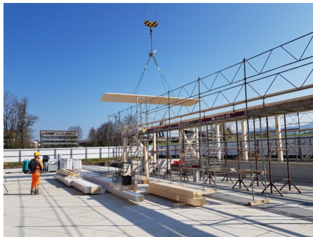
Montage des panneaux CLT
