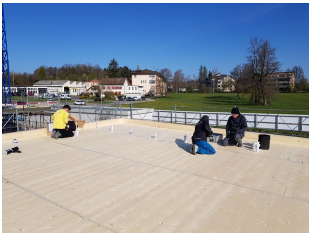
Préparation du scellement TS3
