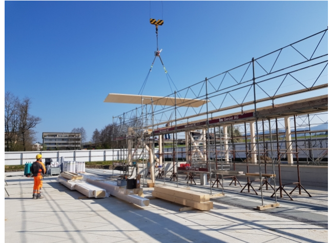
Montage des panneaux CLT
