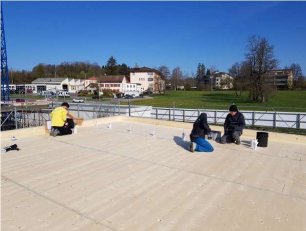
Préparation du scellement TS3
