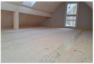
Étage galerie TS3 comme système de surface. Comment intégrer un étage galerie supplémentaire malgré un volume pleinement exploité? Avec le système TS3, le plafond de l'étage galerie peut être fin et sans poutres.
