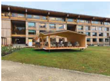
1 La dalle TS3 soumise à rude épreuve: devant la Haute école de Bienne, le pavillon est lesté lourdement afin de tester la résistance du petit balcon en porte-à-faux.
