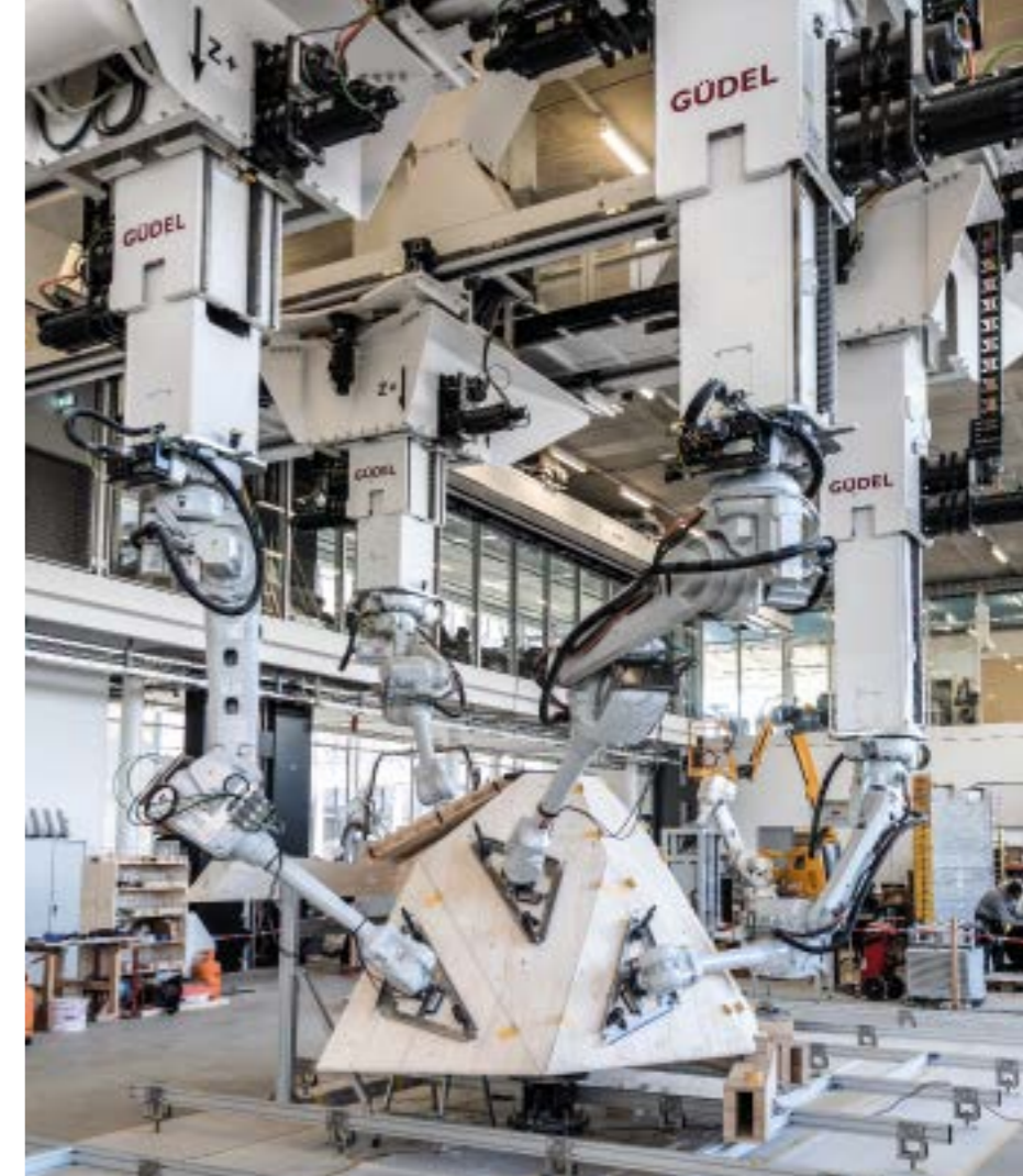
Die Platten sind mittels einer neuartigen Fugenabdichtungstechnologie verbunden: Das Verfahren ermöglicht eine starre Verbindung von größeren Holzplattenkanten
