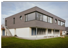
Kindergarten extension, Neuendorf , Neuendorf
