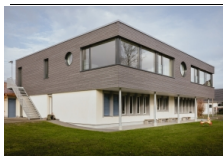
Kindergarten extension, Neuendorf , Neuendorf
