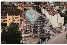
Replacement of Raiffeisenbank, Gebenstorf
