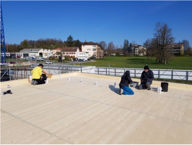
Preparation TS3 pouring
