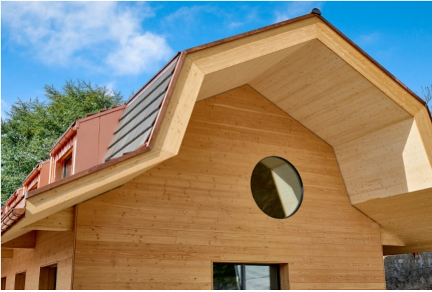
Von aussen und innen: Holz bleibt sichtbar und verleiht dem Gebäude eine angenehme Atmosphäre.
