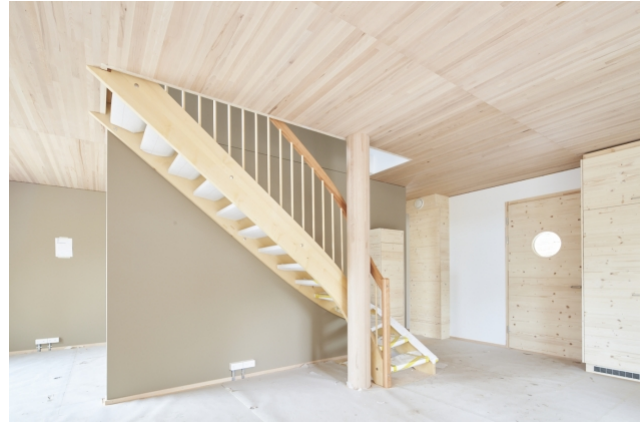
Die TS3-Technologie ermöglicht eine Stützen-Platten Bauweise. Die TS3-Fugen bleiben bei diesem Projekt sichtbar.
