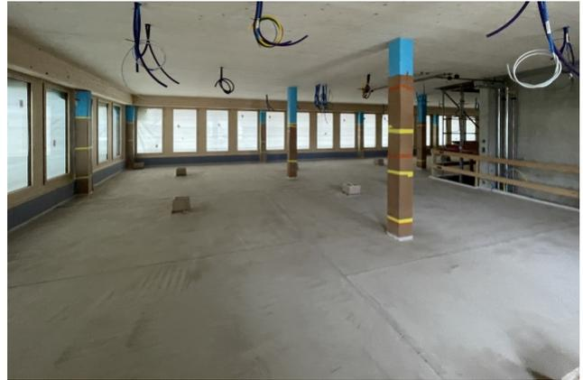
Der Neubau der Raiffeisenbank Wasserschloss in Gebenstorf, entworfen von Merlo Architekten AG, setzt auf die TS3-Skelettbauweise: Stützen und weit gespannte, punktgestützte Brettsperrholzplatten bilden die Tragstruktur, so dass umlaufende Bandfenster ein offenes und helles Ambiente eröffnen. Die weitgespannte Tragstruktur ermöglicht eine flexible Raumgestaltung für die Schalterhalle und die darüberliegenden Büroflächen, welche sich auf die weiteren 3 Geschosse verteilen.
