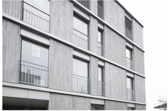
Einst war das Gebäude in Beton geplant. Die TS3-Technologie hat den Wechsel zum Holzbau einfach gemacht.
