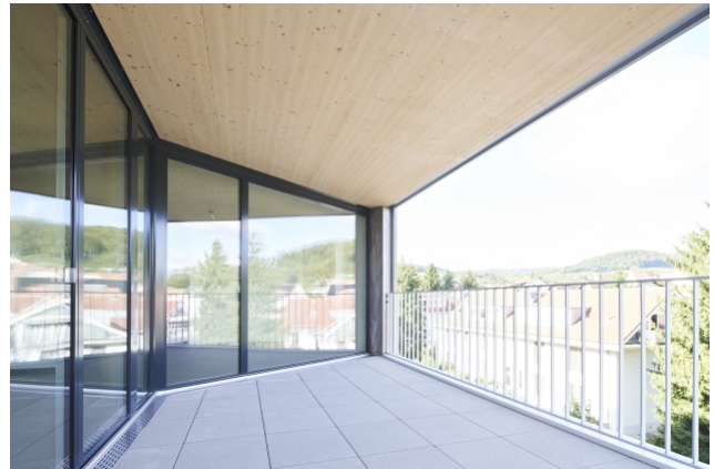
Wärmebrücken einfach gemacht. Die CLT-Decke läuft von der Wohnung zur Loggia einfach durch.
