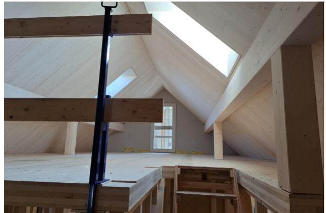
TS3-Galeriegeschoss als flächiges System. Wie kann trotz voll ausgenutzter Kubatur ein zusätzliches Galeriegeschoss noch eingebaut werden? Mit dem TS3-System wird die Galerie-Geschosdecke schlank und ohne Unterzüge möglich.
