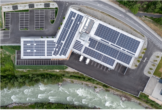
Vogelperspektive des gesamten Gebäudes
