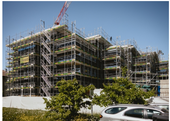
Mehrfamilienhaus Luegisland - Bauphase 2
