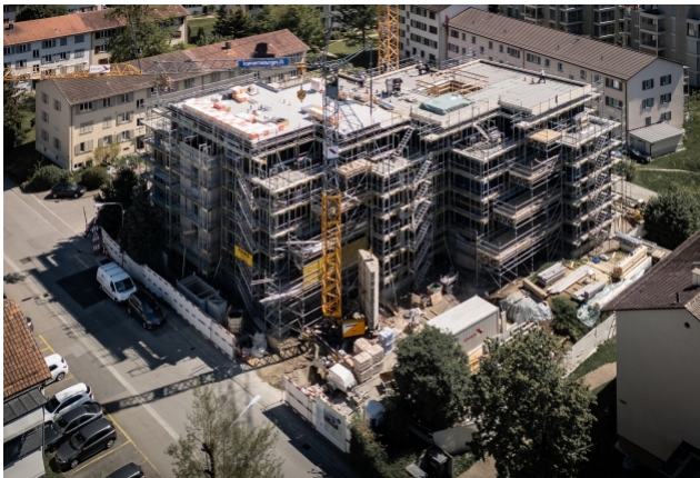
Mehrfamilienhaus Luegisland - Bauphase 1
