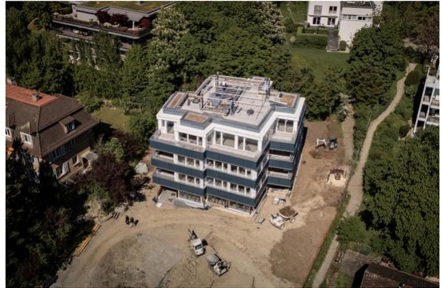
Der Neubau basiert auf einer reinen TS3-Skelettbauweise mit punktgestützten Flachdecken – komplett ohne Unterzüge. Die Decken aus durchlaufenden CLT-Platten verbinden Innen- und Außenräume optisch wie konstruktiv. Balkone und Wohnräume gehen fugenlos ineinander über – eine Schlüsselqualität des TS3-Systems. Die Bandfenster betonen die Offenheit und sorgen für Licht, Sicht und Luftigkeit – unterstützt durch die filigrane Tragstruktur aus dem TS3-Giessharz-Verbundsystem.
