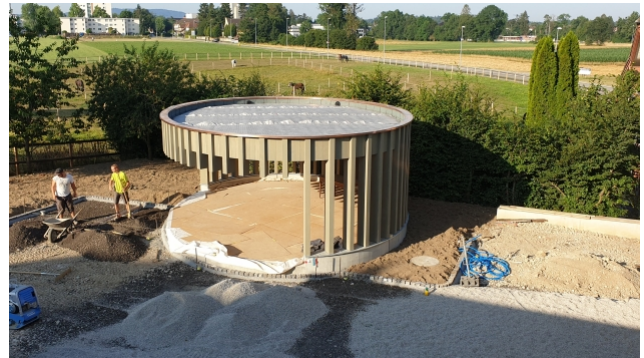
Bauarbeiten Rund um den Pavillon
