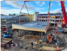
Überdachung Kaserne, Chamblon , Chamblon
