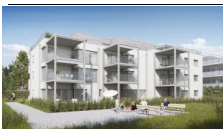
Aufstockung Bahnhofstrasse, Busswil
