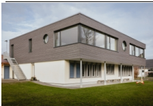
Aufstockung Kindergarten, Neuendorf , Neuendorf
