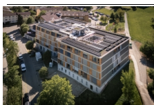
Aufstockung Pflegezentrum im Loo, Esslingen
