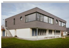
Aufstockung Kindergarten, Neuendorf , Neuendorf
