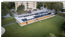
Überdachung Technikgebäude Schwimmbad, Martigny , Martigny
