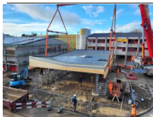
Überdachung Kaserne, Chamblon , Chamblon
