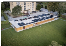
Überdachung Technikgebäude Schwimmbad, Martigny , Martigny
