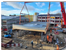
Überdachung Kaserne, Chamblon , Chamblon
