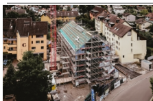
Ersatzneubau Raiffeisenbank, Gebenstorf
