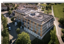
Aufstockung Pflegezentrum im Loo, Esslingen
