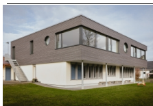
Aufstockung Kindergarten, Neuendorf , Neuendorf
