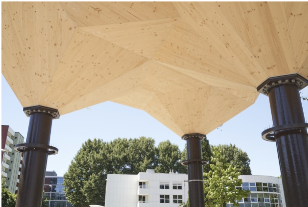
Die Holzschalen werden von acht Stahlstützen getragen
