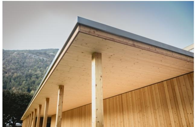
Die Gemeinde Martigny realisierte für ihr Schwimmbad ein neues Technikgebäude mit Umkleidekabinen und Toiletten. Der elegante und funktionale Bau erhielt eine schlanke TS3-Flachdecke. Ohne Balken erscheint die Dachkonstruktion sehr filigran, homogen und leicht.
