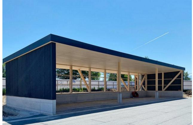
Bauen für die Zukunft! Ein nachhaltiger Bau mit einem gesunden Fussabdruck - das ist eines der wichtigsten Ziele bei der Realisierung des Neubaus der Hustech Installations AG. Die grossen Spannweiten des Vordachs am Hauptgebäude konnten dank der TS3-Technologie relativ schlank gebaut werden.
