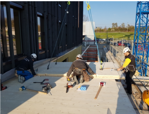
Montage der CLT-Platten
